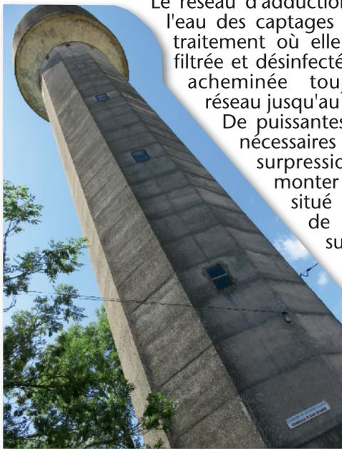
Le réseau d'adduction amène donc l'eau des captages vers l'usine de traitement où elle est décantée, filtrée et désinfectée, avant d'être acheminée toujours par le réseau jusqu'au château d'eau. De puissantes pompes sont nécessaires pour créer la surpression qui la fait monter à son sommet, situé parfois à plus de 100 m au-dessus du sol (si le relief est accidenté et le permet, il est d'ailleurs placé le plus souvent sur un point culminant) ; aussi, le château d'eau se
